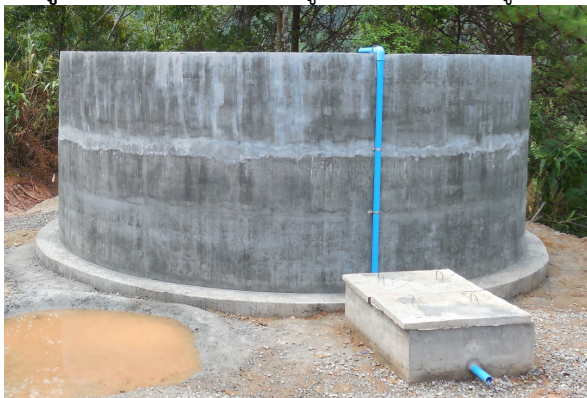
ภาพที่ 7.2 บ่อพักน้ำขนาด 60 ลูกบาศก์เมตร
